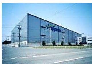
東日本ロジスティクスセンター
